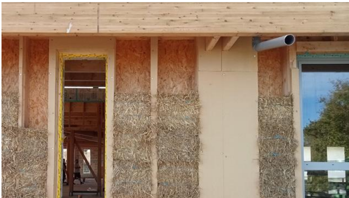
Crèche Les Petits Pieds de Ruelle : mise en œuvre de l'isolant en paille dans la structure en bois.
