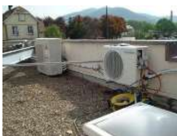
Sur le toit derrière un mur acrotère
