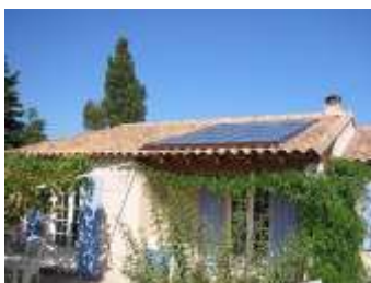
Sur l'arrière du bâti
