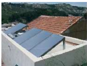
Derrière un mur acrotère en toiture
