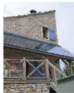
En couverture d'une pergola
