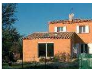
Intégré à la toiture de l'extension
